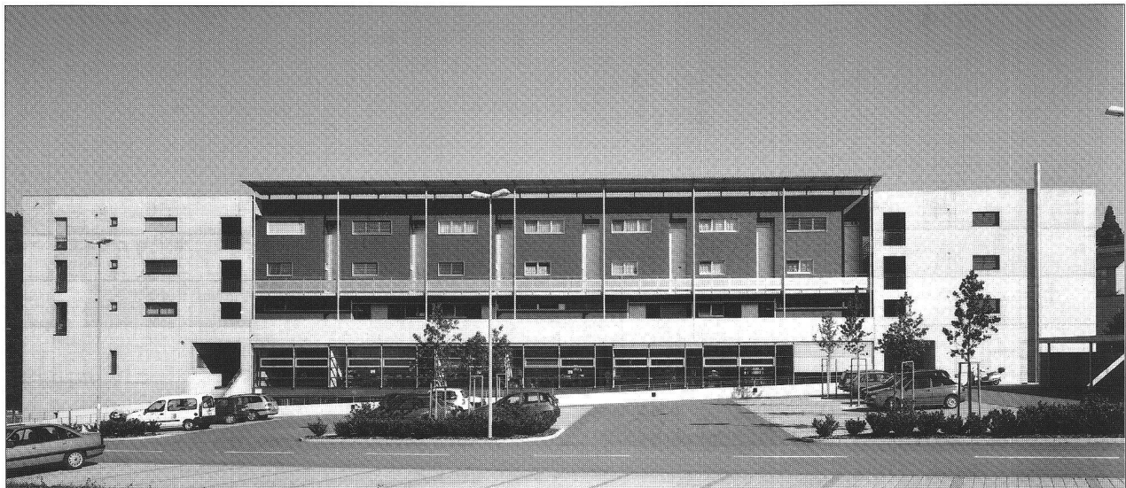
Façade ouest / parking
