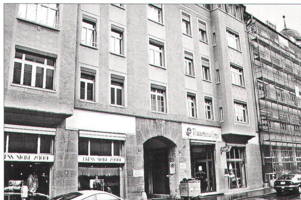
A 300 m du Neumarkt, le centre pour personnes âgées a encore loué les trois étages supérieurs d'un immeuble commercial au rez-de-chaussée duquel se trouve un tea-room. Les locataires qui occupent neuf studios font ménage commun
