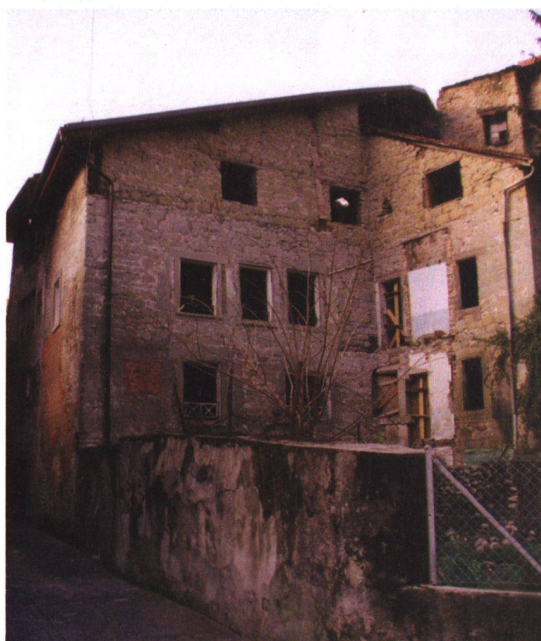
La façade est avant la transformation
