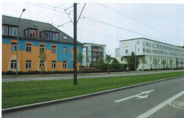
Deux manières totalement différentes de rénover les anciennes casernes bordant le quartier de Vauban.
