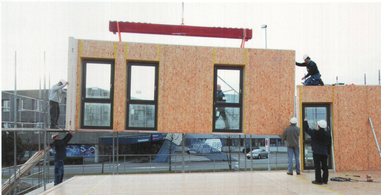
Montage des parois du rez-de-chaussée.
