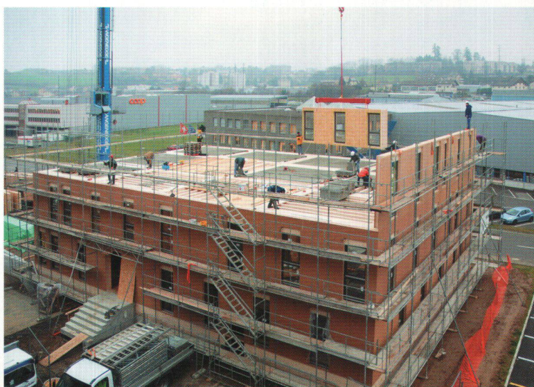
Montage des parois du troisième niveau.
