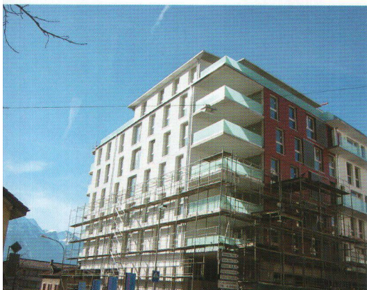
L'immeuble en construction à Clarens (VD).
