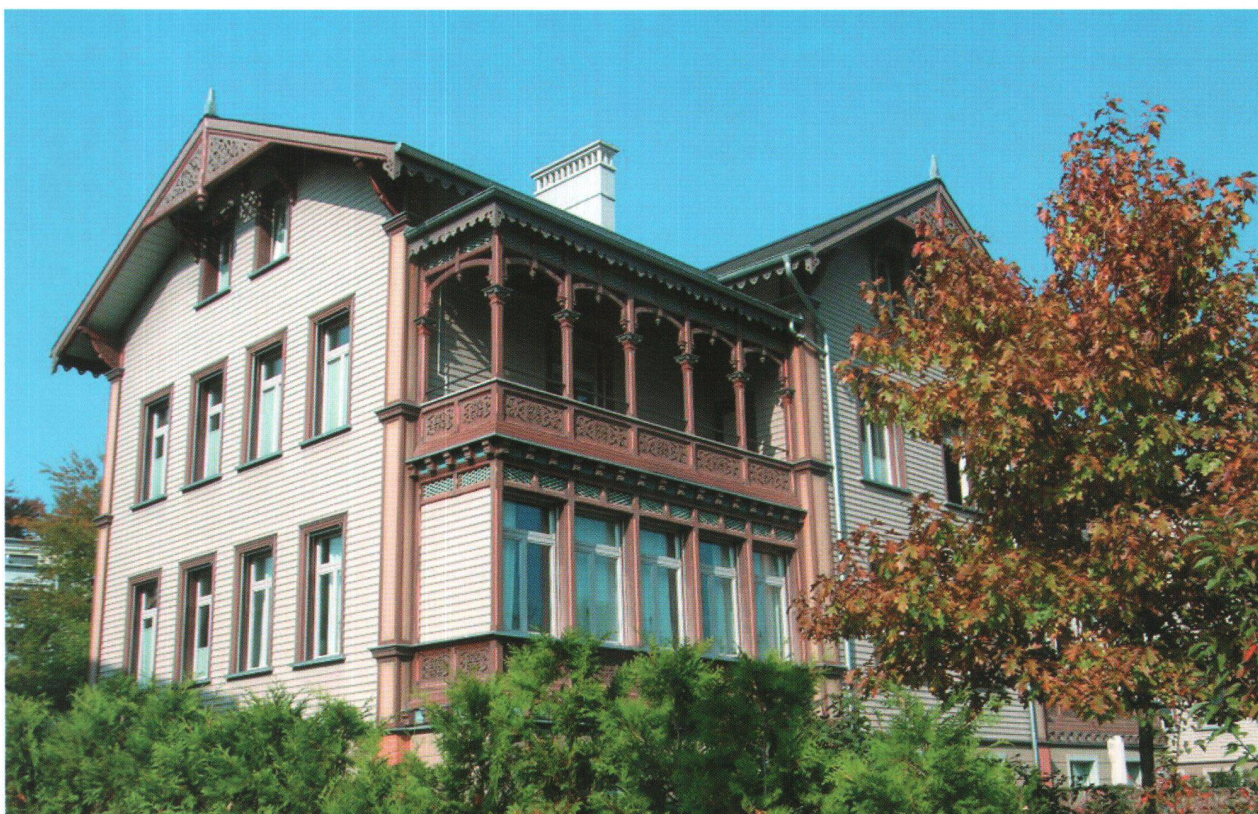
Véranda fermée au rez-de-chaussée et pourvue de fenêtres. La pièce derrière la véranda n'est pas chauffée.
