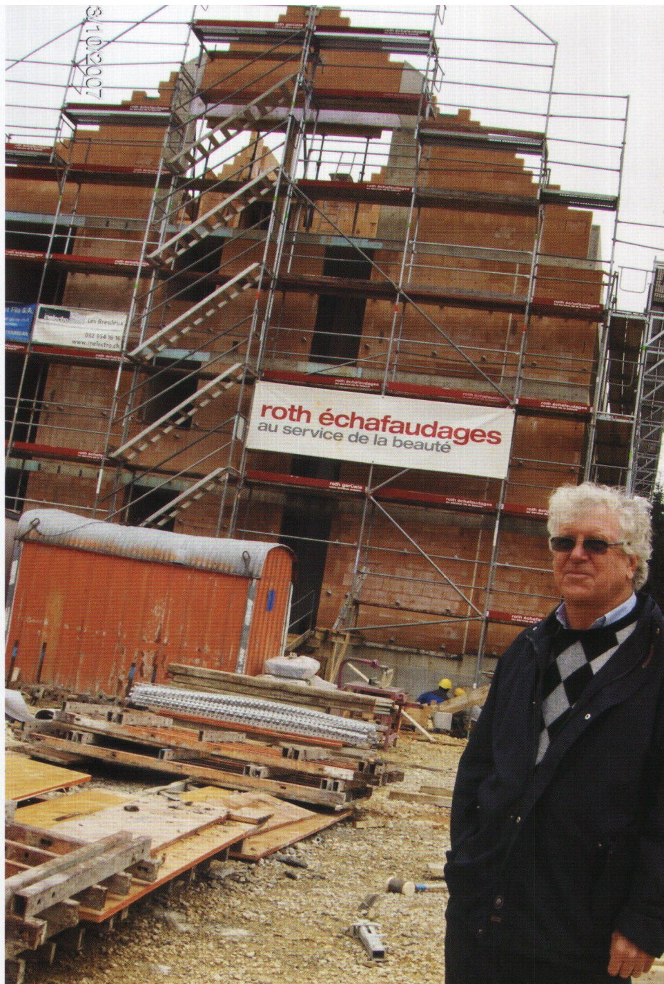
Jean-Michel Boillat, président du conseil d'administration de Ronde Planche SA, sur le chantier du futur immeuble: «Dans les Franches-Montagnes, nous avons appris à ne compter que sur nous-mêmes.»
