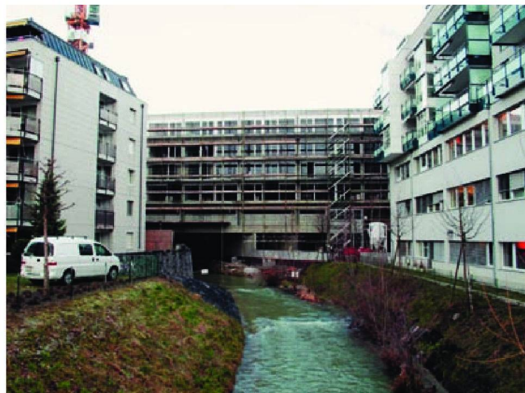
L'immeuble fait pont au-dessus de la rivière.
