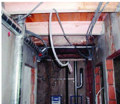
Les 3 étapes de l'installation d'un système de ventilation à double-flux, similaire à ce qui n'a finalement pas été réalisé dans l'immeuble Varnoz 2-4: 1) à gauche, on voit le tuyau principal vertical qui sera ensuite masqué dans le hall d'entrée; 2) au centre, on voit encore la structure de ventilation qui sera cachée par un faux plafond; 3) à droite, le faux plafond qui cache la structure de distribution, dont on ne distingue plus que les grilles amenant l'air dans les pièces. © mcb architectes/DR
