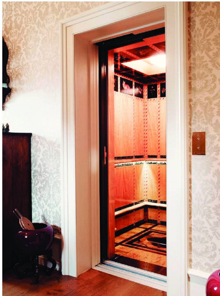
Le superbe décor de la cabine est l'œuvre de l'artiste peintre et décoratrice Emmanuelle Zen Rohrer. L'installation a une charge utile de 800 kg et se déplace à une vitesse de 0,63 m par seconde.
