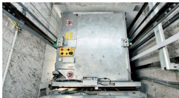
La cabine aux dimensions maximisées s'adapte parfaitement à la cage d'ascenseur actuelle.
