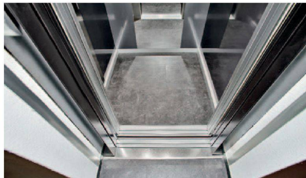
Une transition parfaite: le revêtement linoléum gris en version métallique est identique au sol des étages supérieurs.
