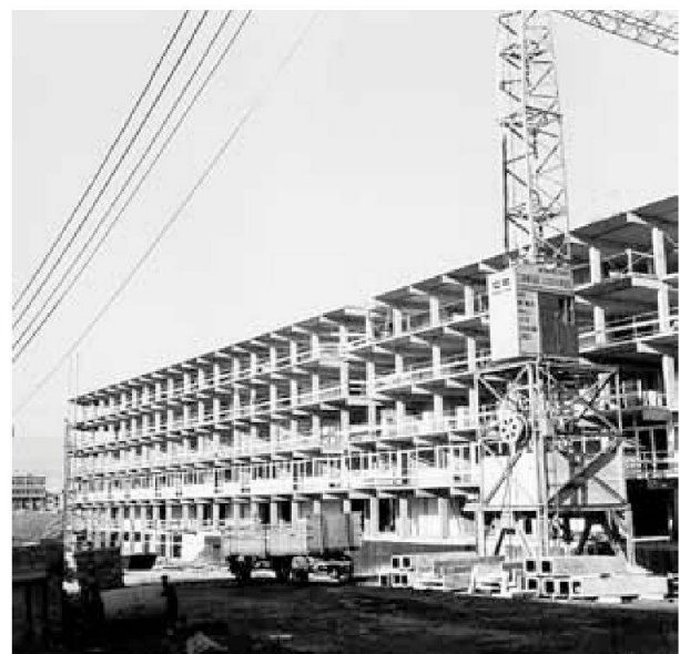
Atelier d'Architectes, immeuble pour la Société coopérative «Les Ailes» (1957- 1959) à Genève, photo de chantier
