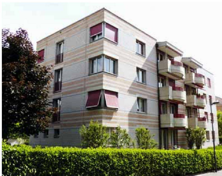
Montolivet 2: 8 logements pour la SCHL 1990
