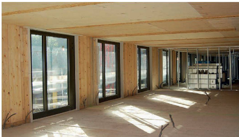
Le gros œuvre est terminé et les étages sont divisés en appartements, au moyen de parois en construction à sec et de cloisons de doublage, avant d'être aménagés. © Knauf AG, Reinach
