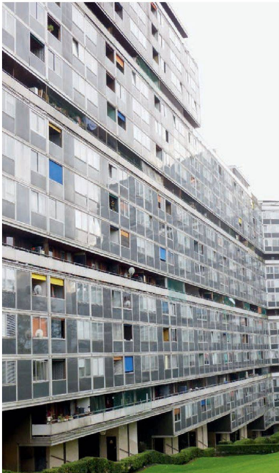
L'amélioration de l'isolation concerne essentiellement les façades-rideaux, vastes de 125 000 m 2 à l'échelle du site. © Borcard
