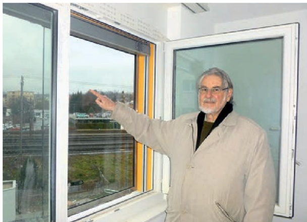
Le président de la SCILMO, Christophe Bonnard, désigne le vitrage de la «chicane à bruit», un dispositif qui permet d'aérer une pièce tout en offrant une protection contre les désagréments causés par un important axe ferroviaire. © VB
