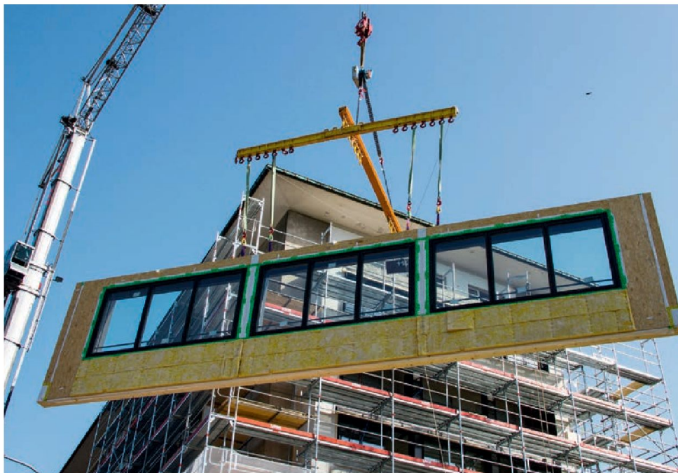
Impact minimum des travaux grâce aux éléments préfabriqués. © Luca FALCIONE/Baud & Früh/DR
