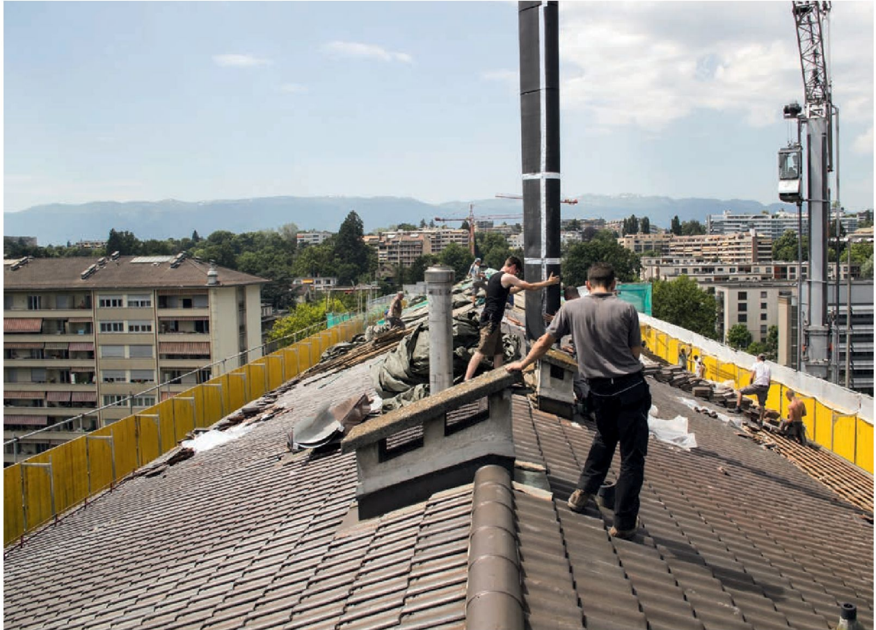
Pose de conduites solaires de 30 m de longueur
