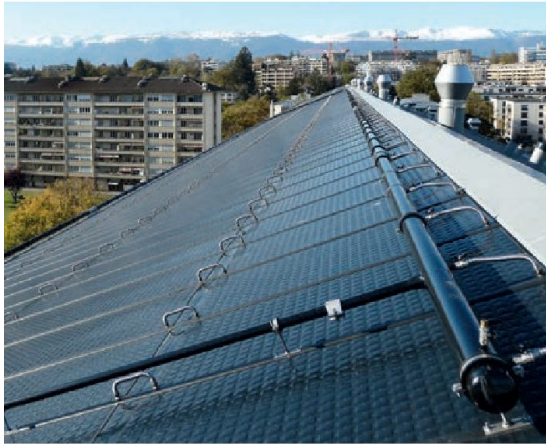
Capteurs solaires thermiques non-vitrés terminés sur Vidollet
