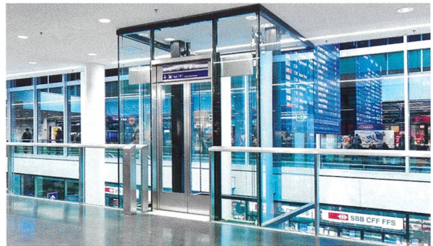
Dans la gare d'Aarau, la transparence des ascenseurs permet une belle visibilité.
