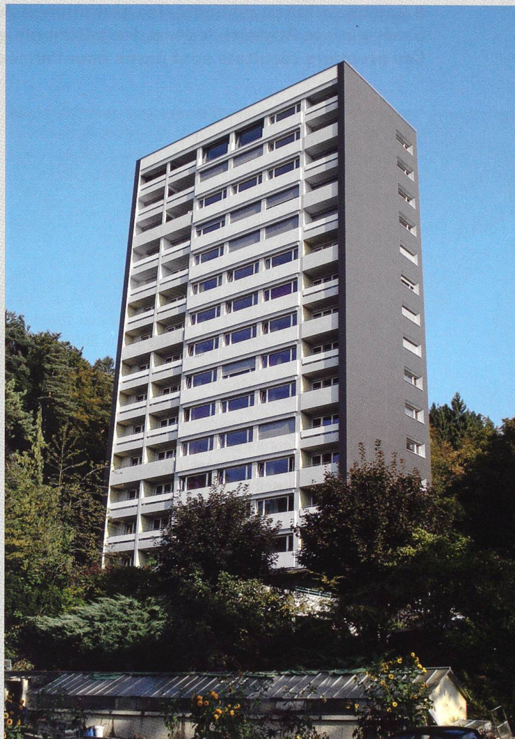
La tour des Cadolles, rachetée par l'Alfen en 2007. Neuf étages sont consacrés au logement étudiant. Alfen/DR
