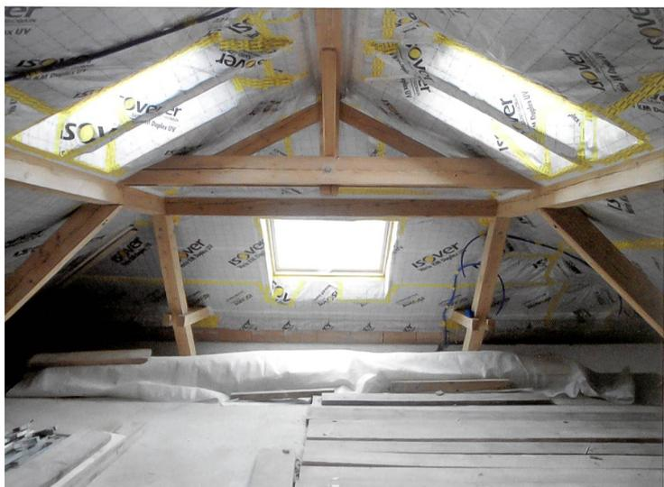
Les panneaux d'isolation sont fixés sous la charpente.
