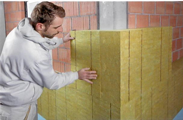
Pose des panneaux d'isolation contre un mur extérieur.
