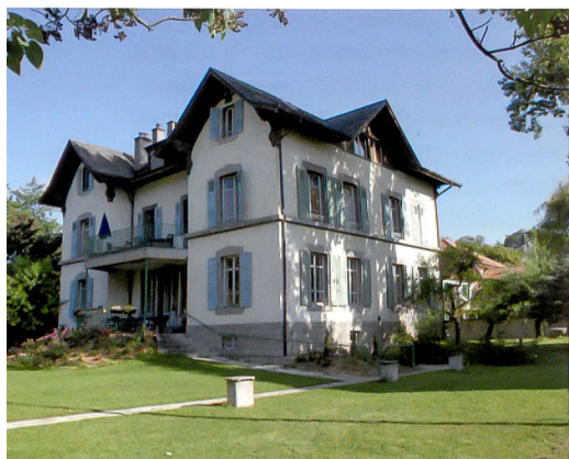
La maison sera rénovée, un immeuble sera construit. Fondation Ensemble/DR
