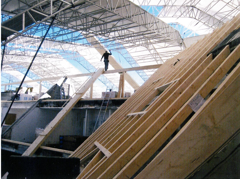
Jusqu'à 18 corps de métiers différents ont été présents simultanément sur le chantier. SCHR
