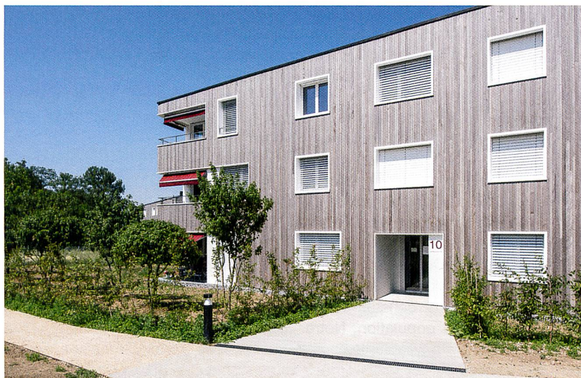
La SCHL privilégie la création de logements adaptés dans ses projets, comme ici à Cheseaux. ©SCHL
