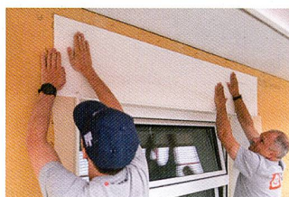
Le système Implio de raccord de fenêtre étanche au vent et à la pluie battante offre l'avantage de réaliser le raccord de fenêtre avec bandeau (panneau de linteau), caisson de volet roulant et/ou de store à lamelles et panneau d'habillage Rivestio ainsi que panneau d'embrasure et en biseau comme deuxième niveau d'étanchéité directement lors de la pose de l'isolation.
