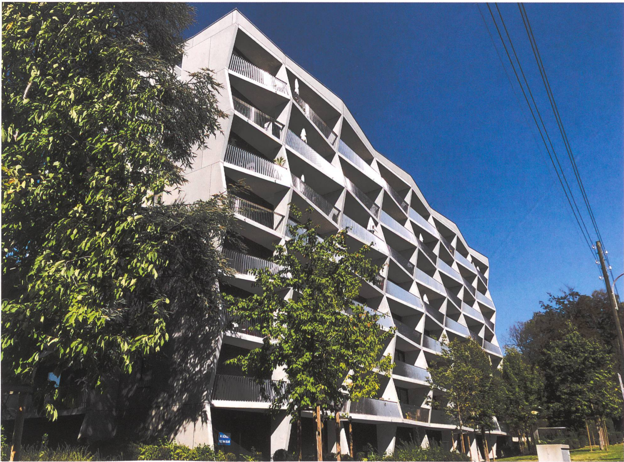
Une réalisation des années 2010, l'immeuble de l'avenue de Joli-Mont (63 appartements). DR
