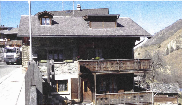
Construite à la sortie sud du village de La Luette, la maison du régent François Moix borde aujourd'hui la route cantonale.
