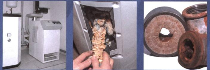
2. Les installations sanitaires sont protégées contre le calcaire. Les tuyaux ne sont plus entartrés. Le tartre déjà présent dans les tuyaux est éliminé. Les points de rouille sont scellés.
