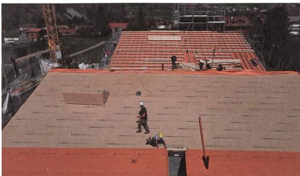
Situé dans un cadre idyllique, l'Hôtel Cailler à Charmey a réalisé une rénovation énergétique de son toit avec les matériaux isolants durables en fibres de bois de GUTEX, certifiés par l'écolabel natureplus®. Les panneaux isolants éprouvés GUTEX DW+ disposent d'une densité brute particulièrement élevée permettant des propriétés de panneaux encore plus résistantes à la pression
