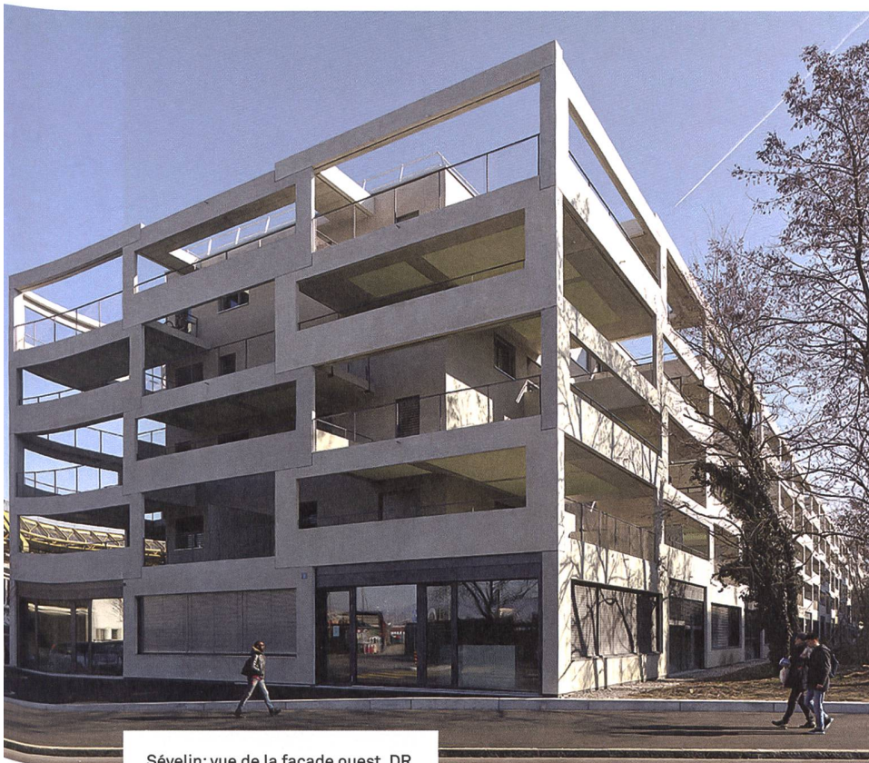
Sévelin: vue de la façade ouest. DR
