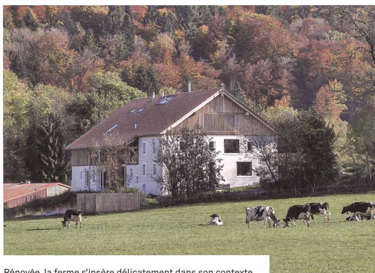
Rénovée, la ferme s'insère délicatement dans son contexte.
