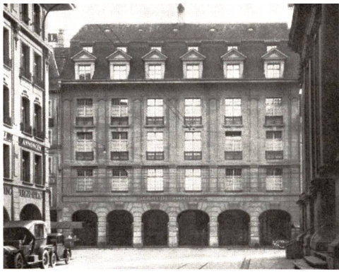
Warenhaus Loeb, Spitalgasse 51, Neubau von 1913. Der Vorzustand ist abgebildet im Mitteilungsblatt 1999, S. 10.
