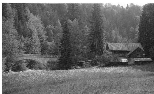
Abb. 5+6 Die alte Schwarzwasserbrücke mit der ehemaligen Wirtschaft
