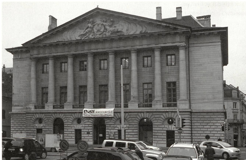
Rathaus von Neuenburg, Gebrüder Raymond nach Plänen von Pierre-Adrien Pâris, 1784-1790 (Foto DS)
