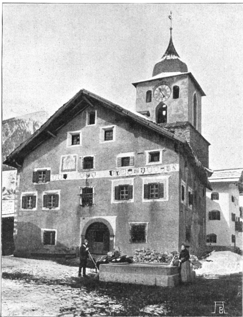
DAS HOCHGERICHTSGEBÄUDE ZU BERGÜN vor der Restauration LA MAISON DU TRIBUNAL A BERGUN avant la restauration
