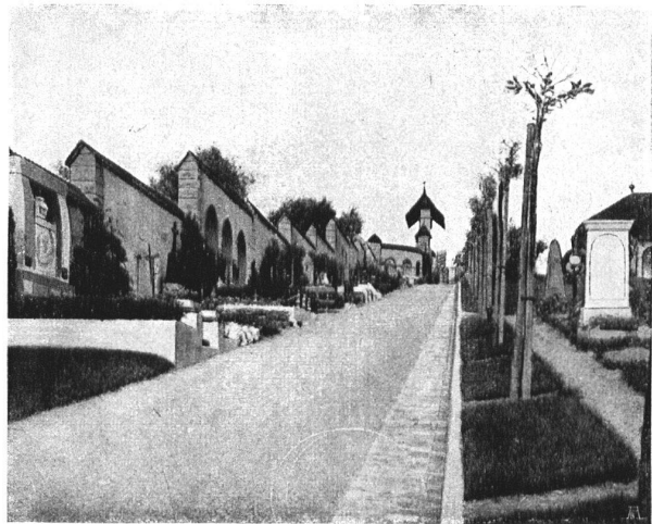
PARTIE VON DER UMFASSUNGSMAUER DES NEUEN FRIEDHOFS „ENZENBÜHL“ in Zürich MUR D'ENCEINTE DU CIMETIÈRE ENZENBÜHL à Zurich
