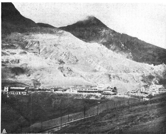
DIE VERUNSTALTUNG DER KLEINEN SCHEIDECK DURCH ZWECKBAUTEN
