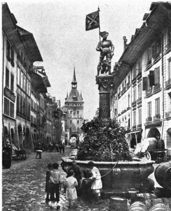
DER SCHÜTZENBRUNNEN AN DER MARKTGASSE ZU BERN FONTAINE DE LA RUE DU MARCHÉ A BERNE Phot. Verlag Wehrli A.-G. in Kilchberg b. Zürich
