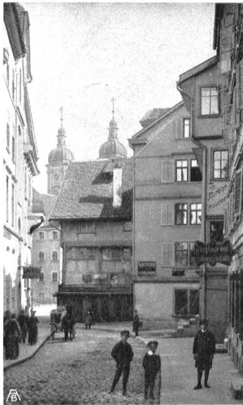
GALLUSSTRASSE früher „im Loch“. Die vor einigen Jahren gezogene Baulinie wird das den guten Abschluss des Gallusplatzes gegen diese Gasse bildende Haus „zur Linde“ wegrasieren und damit den geschlossenen Charakter des Platzes, eines der reizvollsten Bilder der alten Stadt, ohne zwingenden Grund vernichten. RUE DE GALLUS. La maison qui ferme la place est condamnée par le plan d'extension, au détriment de l'unité architectonique; un des coins les plus intimes de la ville sera détruit.
