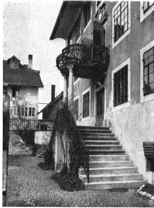
Freitreppe und Balkon der Hoffassade; von der Gottfried Keller-Stiftung und der Landesmuseumskommission zur Aufstellung am Landesmuseum in Zürich angekauft Escalier extérieur et balcon de la façade cour, achetés par la fondation Gottfried Keller et par la Commission du Musée National pour être exposé au Musée National à Zurich
