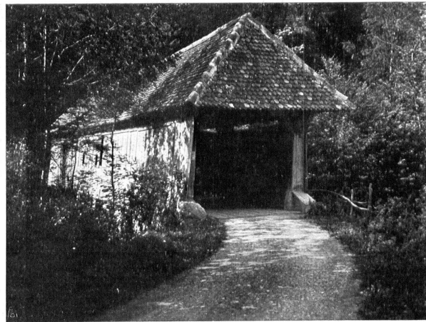
Die Suwaroff-Brücke im Muottatal, malerisch alte Holzbrücke. Photographie von Frau Dr. L. Stumm, Basel.
