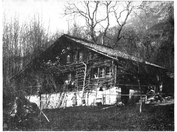
Abb. 10. „Gadenhaus“ in Flüelen, Dach erneuert. Fig. 10. Ferme à Flüelen, avec toit reconstruit.
