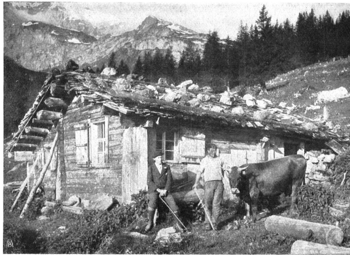
Abb. 11. Sennhütte auf dem Urnerboden.
