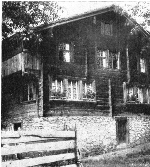
Abb. 17. Haus des Ratherrn Alois Gerig im „Buchholz“, Silenen. Fig. 17. Maison du Conseiller Alois Gerig à „Buchholz“, Silenen.
