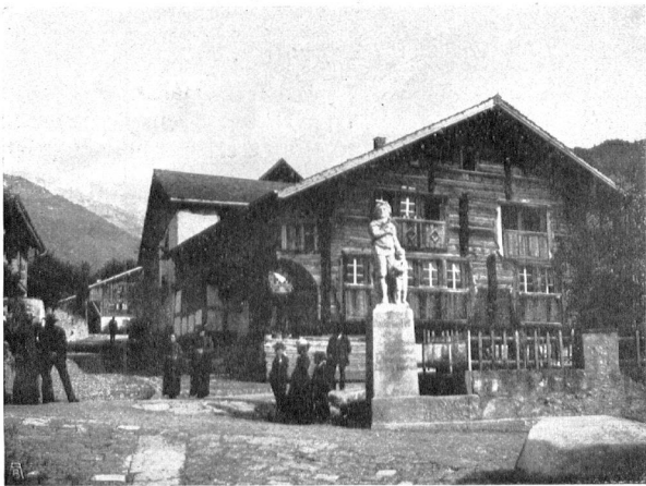
Abb. 5. Gasthaus zum „Adler“ in Bürglen vor der Restauration. Fig. 5. Auberge de „l'Aigle“ à Bürglen, avant sa restauration. Photographie von Paul Siegwart, Aarau.
