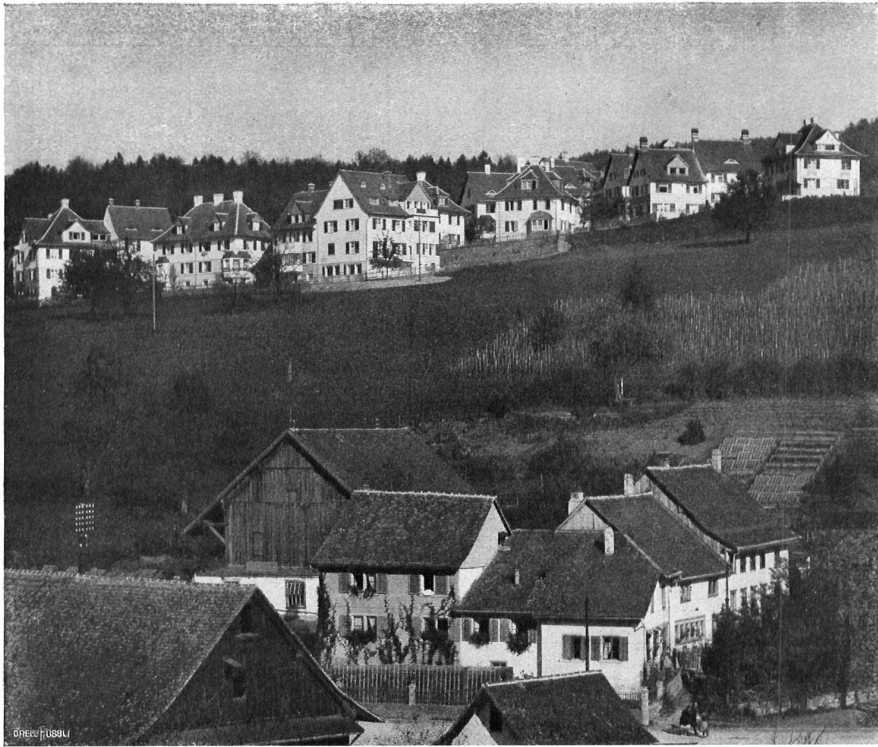
Bergheim bei Zürich von Gebrüder Pfister, B. S. A. Gerade weil jedes Haus frei nach dem Bedürfnis gestellt wurde, statt nach einer schematischen Formel, entstand oben das gleiche Bild wie bei den alten Häusern unten.
