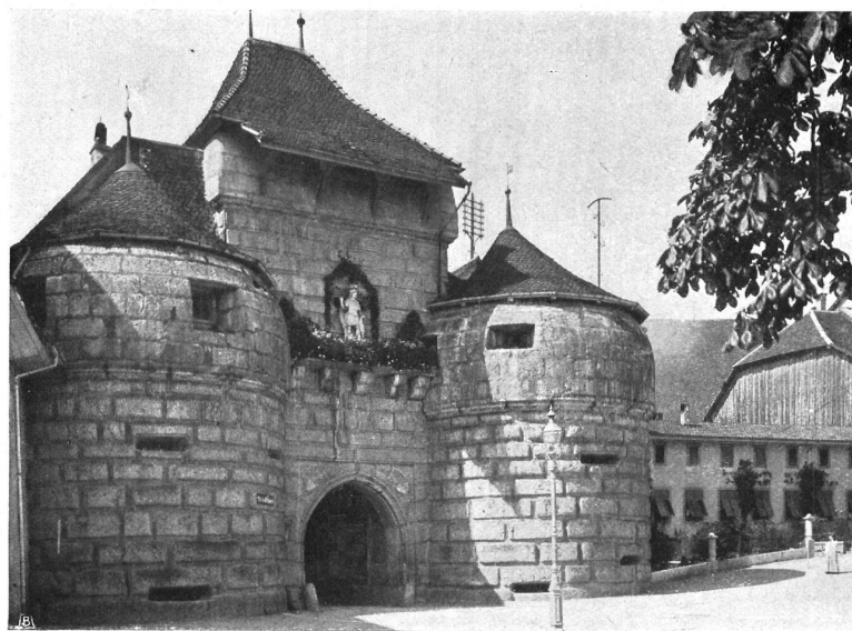
Abb. 8. Basler Tor. Letzter machtvoller Torbau der alten Stadtbefestigung. Aufnahme von Photograph Ernst Glutz .
