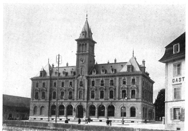
Abb. 10. Gegenbeispiel . Eidgenössische Post. Ohne jede Rücksicht auf die örtliche Bautradition im üblichen offiziellen Stil und landesfremdem Material gebaut. Aufnahme von E. Saladin . — Fig. 10. Mauvais exemple. La poste fédérale. On n'a tenu aucun compte de la tradition locale. Style officiel et banal. Matériaux étrangers. Cliché E. Saladin .
