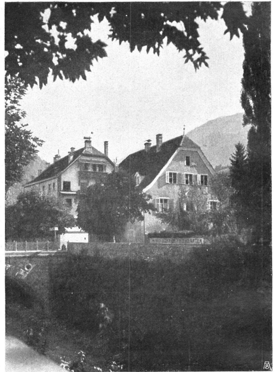
Turligartenhäuser am Plessurquai (Haus Secchi). Vorbildlich mit dem Garten zusammenkomponiert. Im ganzen Bau ist die elegante Art des spätern 18. Jahrhunderts lebendig. — Maison du Turligarten , vue du quai de la Plessur (maison Secchi). Modèle de construction en parfaite harmonie avec le jardin. Les formes agréables de ce bâtiment offrent un excellent exemple du style élégant en honneur à la fin du XVIII e siècle.
