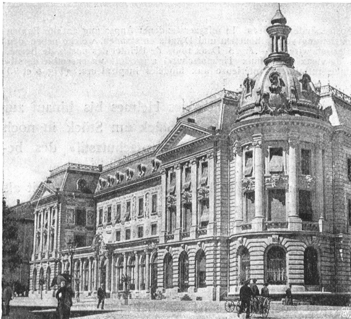
Abb. 4. Eidg. Postgebäude in Chur. Die Kuppel des Prunkgebäudes ist noch überladener als bei den andern Postbauten. — Fig. 4. Hôtel des postes fédérales de Coire. La coupole du palais prétentieux est encore plus surchargée que dans les autres édifices postaux.
