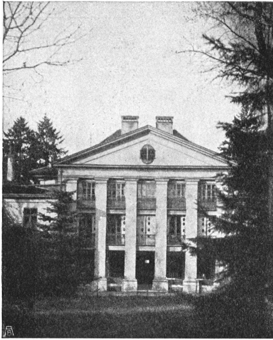
Abb. 10. Haus der Familie Feer, Gartenansicht. Die Pilaster ermöglichen volle Ausnützung von Licht und Luft ohne Störung der Gesamtwirkung. Aufnahme von K. Ramseyer. — Fig. 10. Maison de la famille Feer, vue du jardin. Les pilastres permettent le libre accès de la lumière et de l'air, sans nuire à l'effet d'ensemble.
