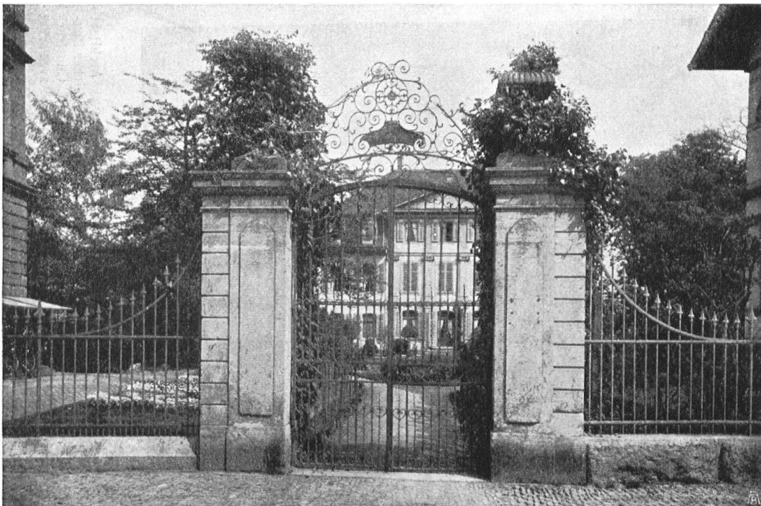
Abb. 13. Portal des Schlossgartens. Geschmiedetes Eisengitter und schöner Pflanzenschmuck. Fig. 13. Portail du Schlossgarten. Grille de fer forgé et décoration de plantes.
