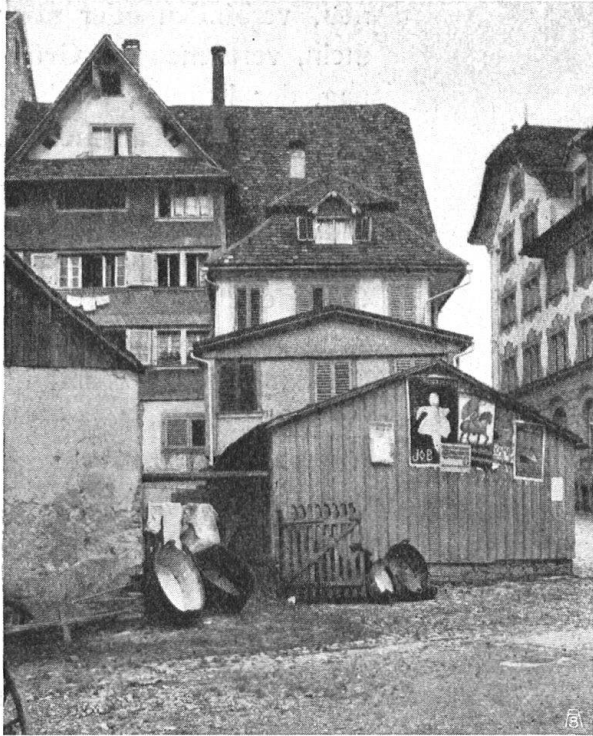
Abb. 12. Partie aus Einsiedeln mit charakteristischen Dachformen. Die Reklamewand wirkt hässlich, weil die Plakate ohne Ordnung durcheinander und übereinander geklebt sind. Fig. 12. Groupe de maisons à Einsiedeln. Toits aux formes caractéristiques. La paroi réservée aux réclames produit un effet désagréable, parce que les affiches sont placées sans ordre les unes à côté ou au-dessus des autres.
