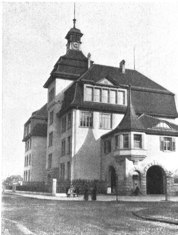
Abb. 16. Moosmatt-Schulhaus in Luzern. (Architektur der städtischen Baudirektion.) Die kleinen Giebel, der Turm, der Erker gehören ins Kapitel „falscher Heimatschutz“. Fig. 16. Ecole de la Moosmatt à Lucerne. Produit de l'architecture officielle de la ville. Les pignons minuscules, la tour, l'encorbellement appartiennent au genre dit «faux Heimatschutz».
